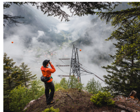
Blick in die Zukunft – die bestehende Gotthardleitung wird ersetzt.
